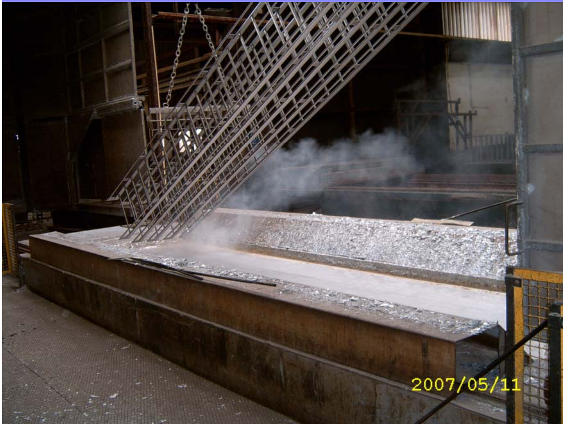
Figura 1. Galvanizadora de la empresa Niedax Kleinhuis. Imagen cedida por Niedax Kleinhuis
