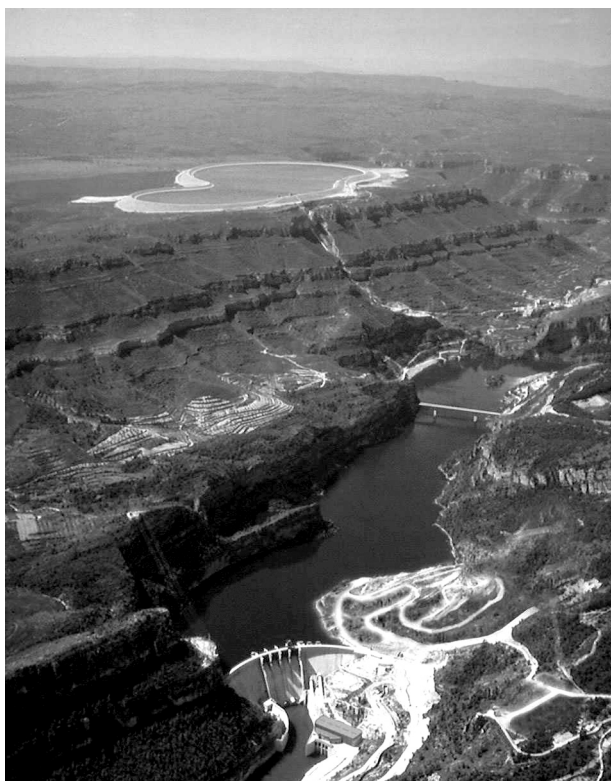
Figura 1.5. Central de bombeo puro de Cortes-La Muela, Valencia (por cortesía de UNESA).
