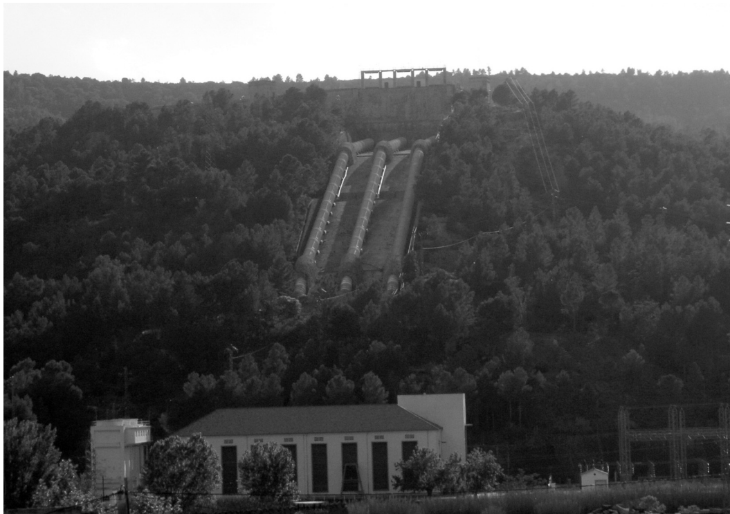
Figura 1.3. Central de salto por derivación de Cofrentes, Valencia.
