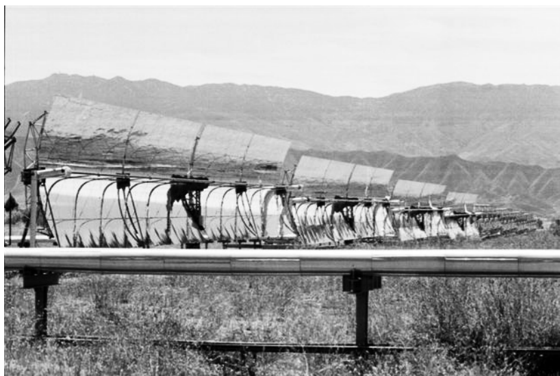
Figura 1.17. Plataforma Solar de Almería: colectores cilíndrico-parabólicos (por cortesía del prof. M. Castro).
