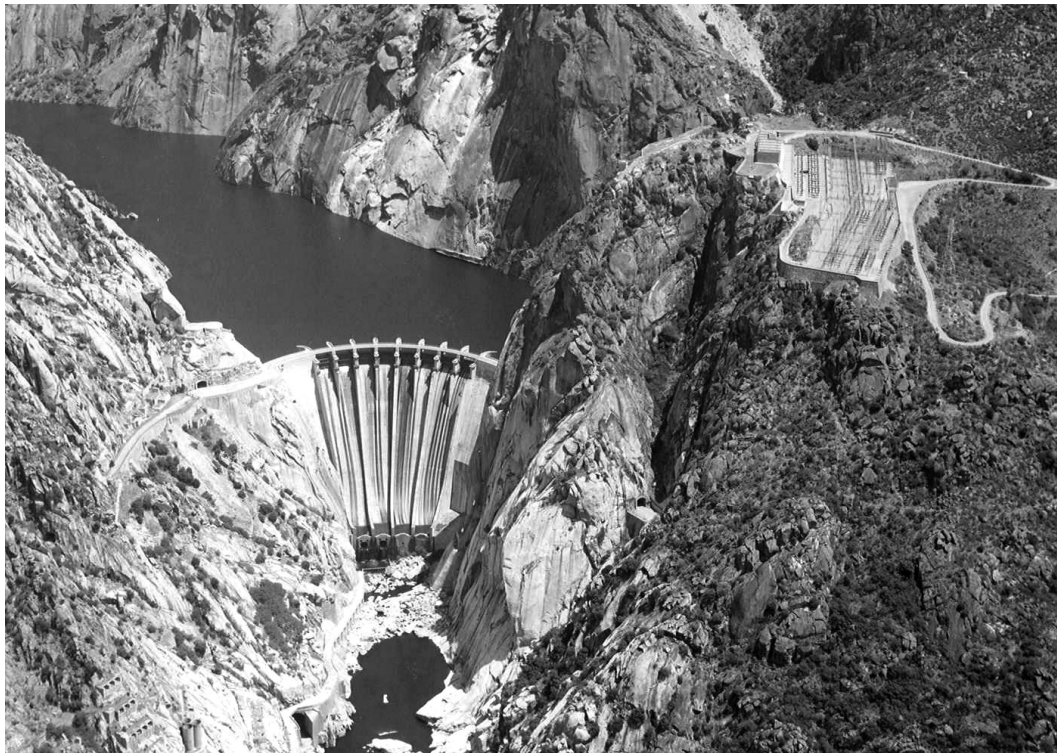
Figura 1.4. Tipos de presas: (arriba) de gravedad, central de José M o de Oriol, Cáceres, y (abajo) de bóveda, central de Aldeadávila, Salamanca (por cortesía de UNESA).
