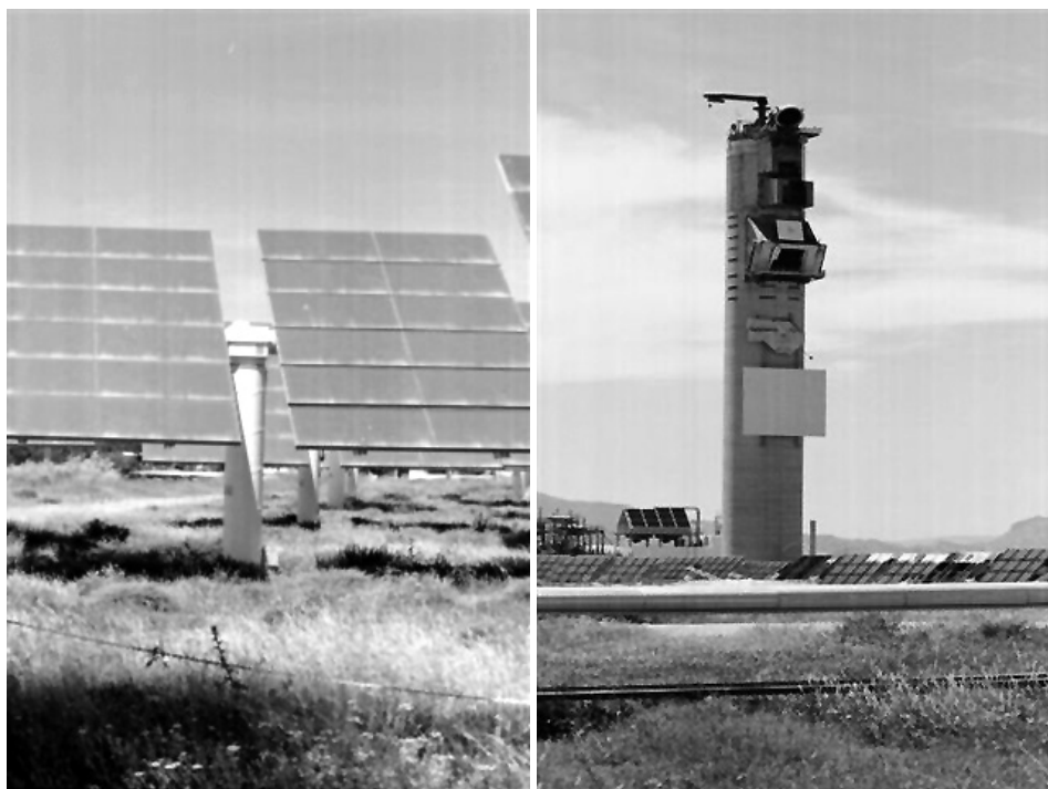
Figura 1.16. Plataforma Solar de Almería: (izquierda) helióstato y (derecha) torre central con la caldera solar (por cortesía del prof. M. Castro).
